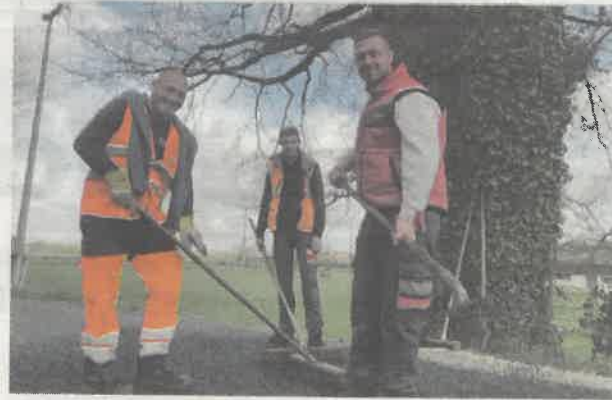
La dernière touche, après une semaine de travaux. JDI (R.L)
